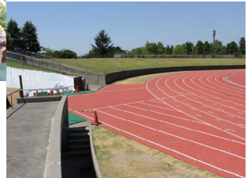
2013年5月 バック側直走路改修
