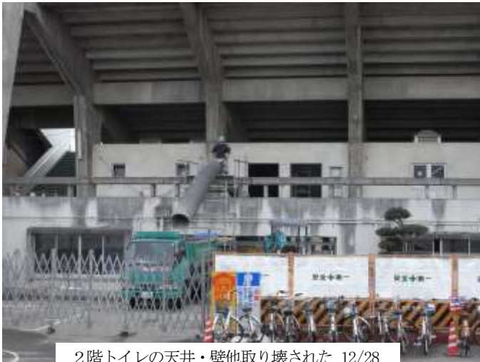
2階トイレの天井・壁他取り壊された 12/28
